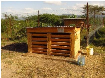
Nachdem der Beton zwei Tage getrocknet war haben wir angefangen das Grundgerüst mit Brettern zu verkleiden. Da es die Kompostwürmer nicht zu trocken und zu heiß mögen, haben wir uns entschieden eine Isolationsschicht rund um den Kompost zu bauen, diese haben wir daher mit Sand gefüllt. Außerdem hat der Kompost noch ein Dach bekommen, das gegen Regen und Sonne schützt.
