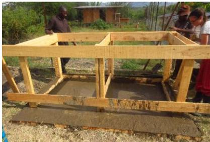
Zusammen mit Jackson und Mathew haben wir das Fundament auf kenianische Weise gegossen: Zunächst haben wir auf dem Boden vor dem Kompost einen Haufen aus Sand, Kies und Zement aufgeschichtet. Anschließend wurde dieser dann, zusammen mit Wasser, Stück für Stück mit der Schaufel zu Beton durchgemischt. Ein Betonmischer war zwar vorhanden und einsatzbereit, wurde jedoch nicht als nötig erachtet, da es sich lediglich um 700 Liter Beton handelte.
