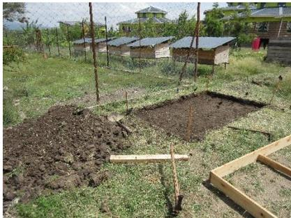
Nach dem Bau des Grundgerüsts vom Kompost haben wir als nächstes einiges an Erde ausgehoben, damit wir das Fundament gießen konnten. Dieses ist notwendig, damit Termiten das Holz nicht direkt von unten aus der Erde angreifen können.
